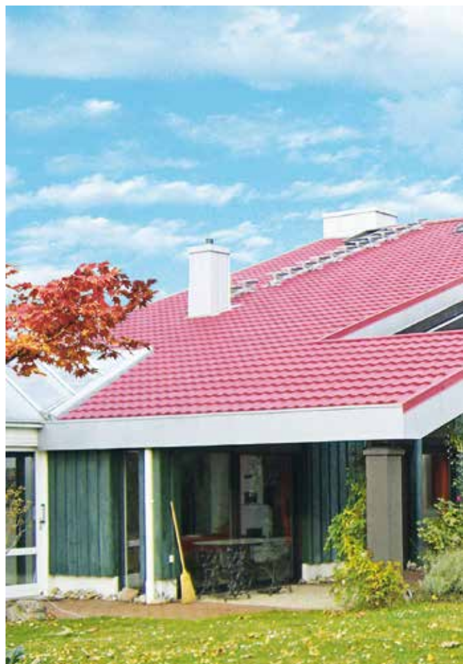
Die Leichtigkeit auf dem Dach. Mit Decra Metallplatten
