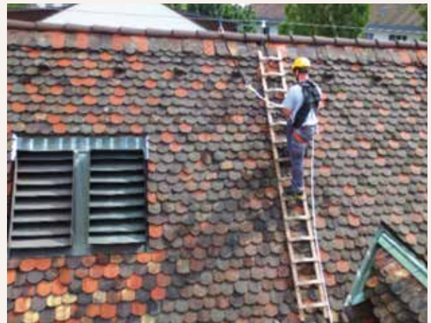
Absicherung über die persönliche Schutzausrüstung direkt am Dachfirst.
