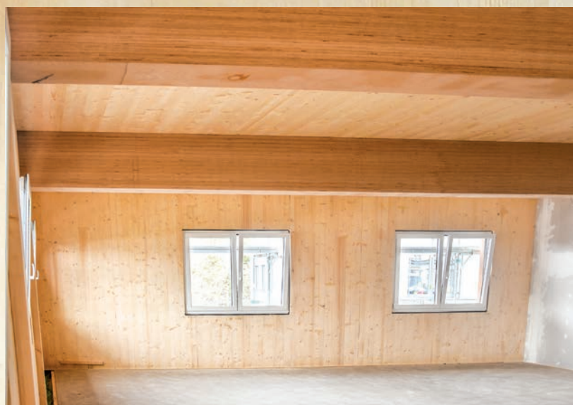
Das Team verbaute Buchenholzbinder mit einer Spannweite von 10 m.
